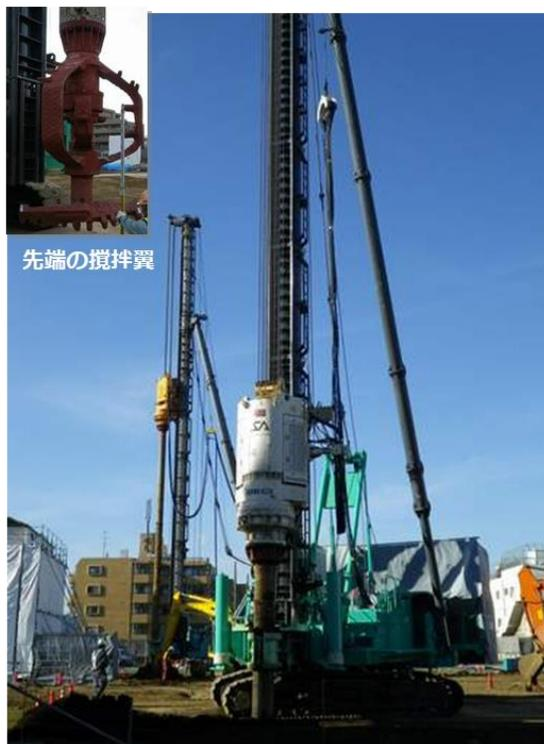
写真2 大型機械による鉄粉攪拌混合
