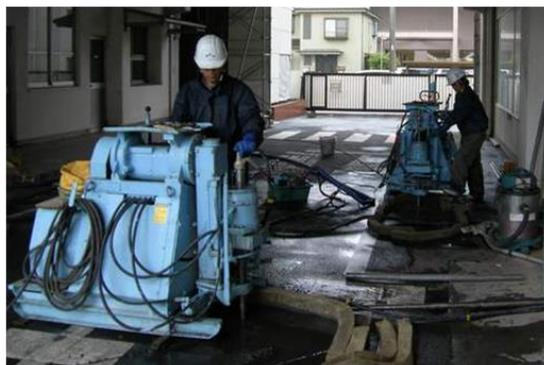
写真1 小型機械による鉄粉注入
